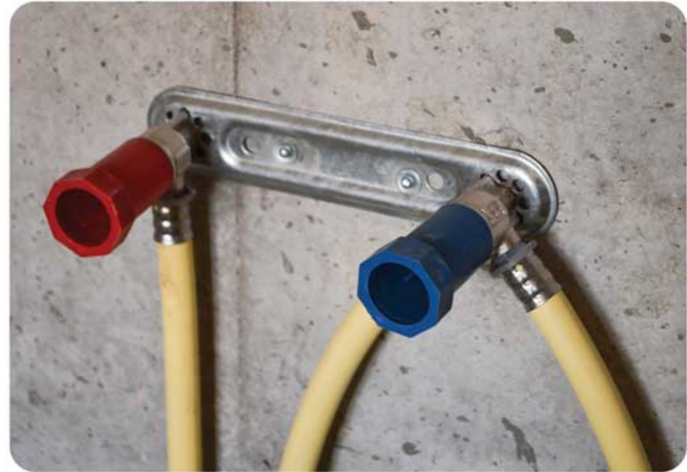
استفاده از سه راهی تبدیل 16 \times 1/2 \times 16 و زانو دیواری 16 \times 1/2 ✓
