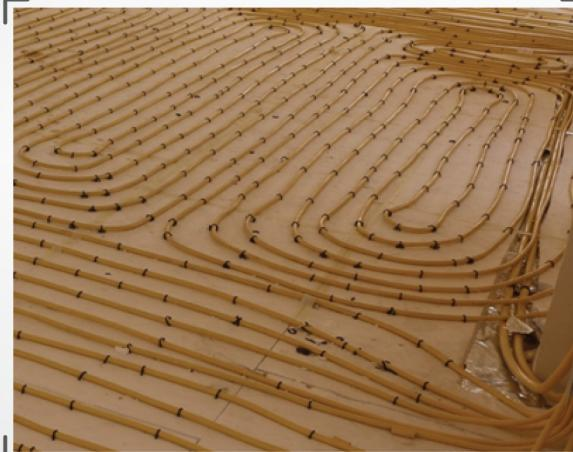
■ انجام تئینات سقف‌ها مانند اجرای سقف کاذب، رابیتس و اجرای نما و گچ کاری ساختمان لازم است پیش از شروع اجرای گرمایش از کف نهایی شده باشد. همچنین لازم است پیش از اجرای گرمایش از کف، کاشی‌کاری سطوح به اتمام رسیده باشد.
